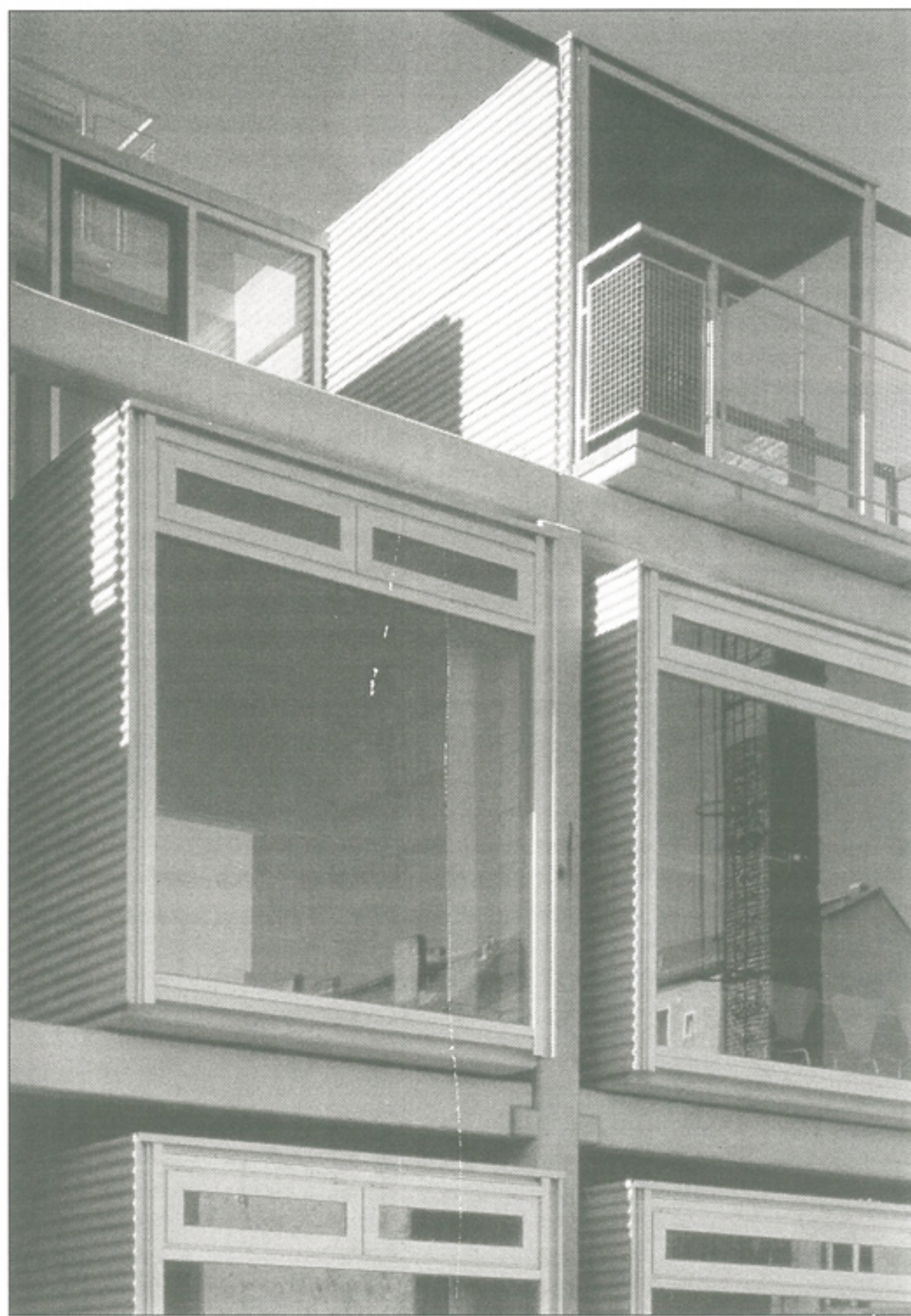
Voor de renovatie van een oud flatgebouw in het Duitse Rathenow ontwierpen de architecten Jochen Keim en Klaus Sill een frame voor de oude gevel waardoor extra blokken aan de flat gekoppeld kunnen worden. (Foto: Elma Durmisevic)
